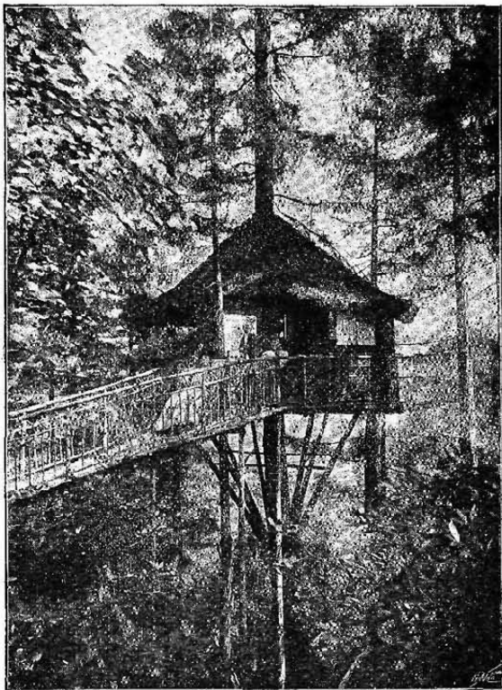
CASA CONSTRUÍDA EN UN GRAN ARBOL, Á 50 PIES DE ELEVACIÓN
