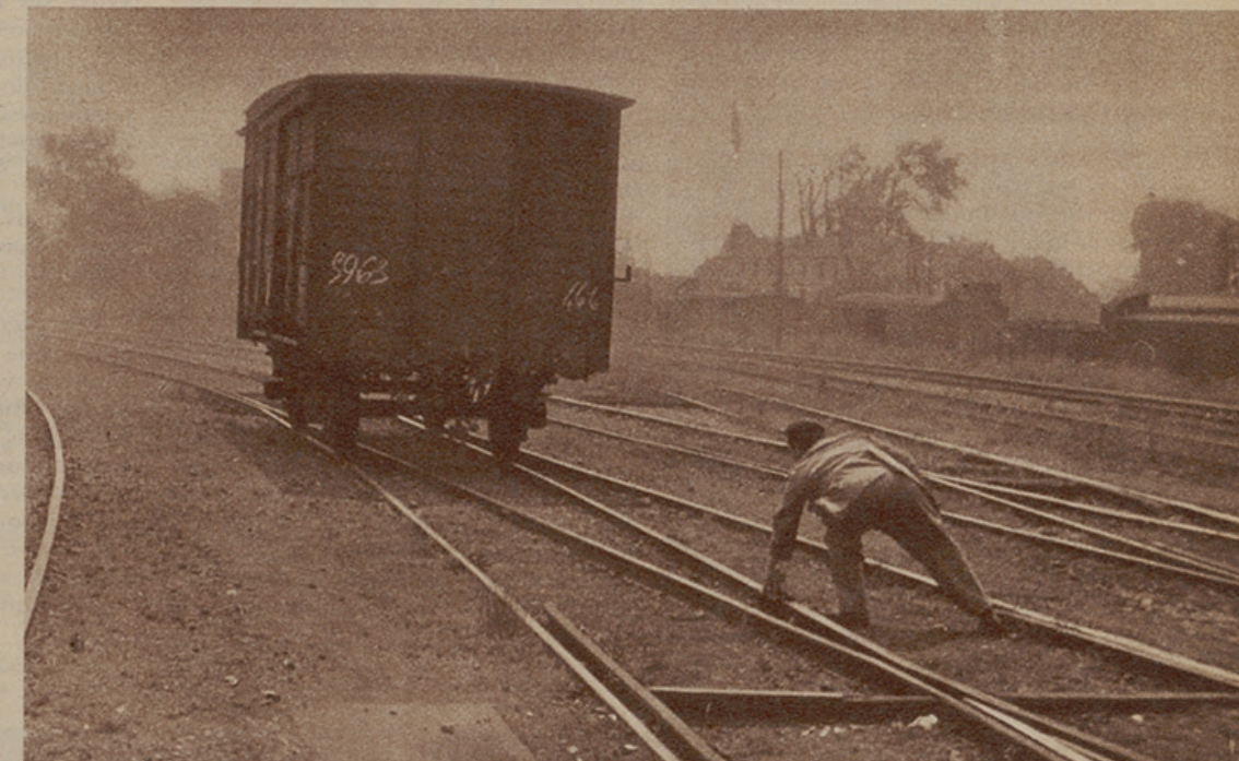
Les wagons dévalent sur les voies en éventail. Le « saboteur » court de l'un à l'autre pour ralentir leur vitesse en glissant adroitement le sabot sous les roues.
