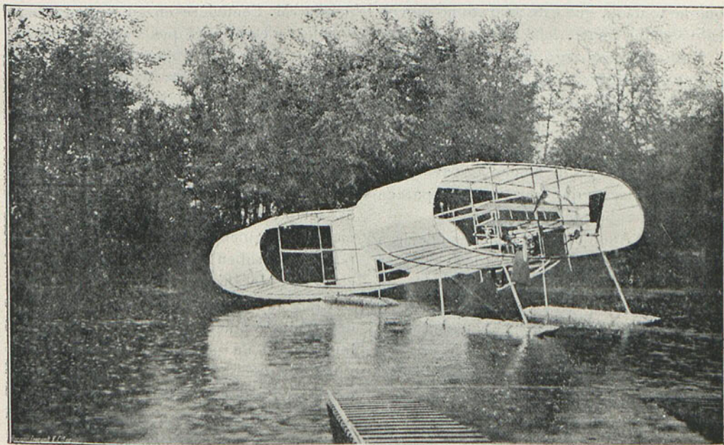
El aeroplano n.º 3, construido por Voisin y experimentado en 1906 sobre el lago d'Enghien (De L'Aviation, de Ferber)
