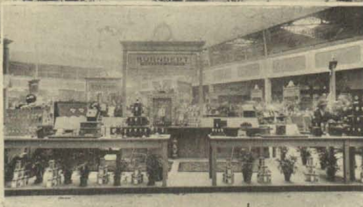
Detalle parcial de algunas de las instalaciones
