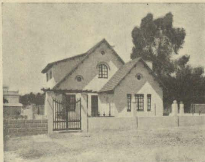
Vista general del edificio
