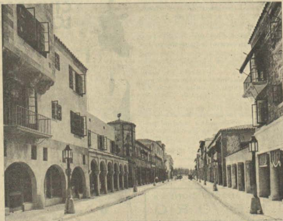
Una calle de Miami, de carácter típicamente español, prueba del cuidado con que fué proyectada y edificada la moderna estación de invierno americana
