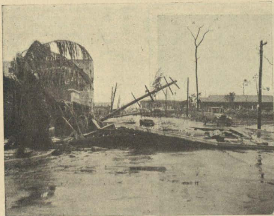
Aspecto de una de las más importantes calles de Miami después del cataclismo que devastó toda la Florida
