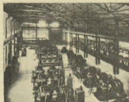
Salón de máquinas. En último término tres máquinas 165 HP. acopladas a dinamos de corriente continua, que surten de energía a los generadores que aparecen en primer término
