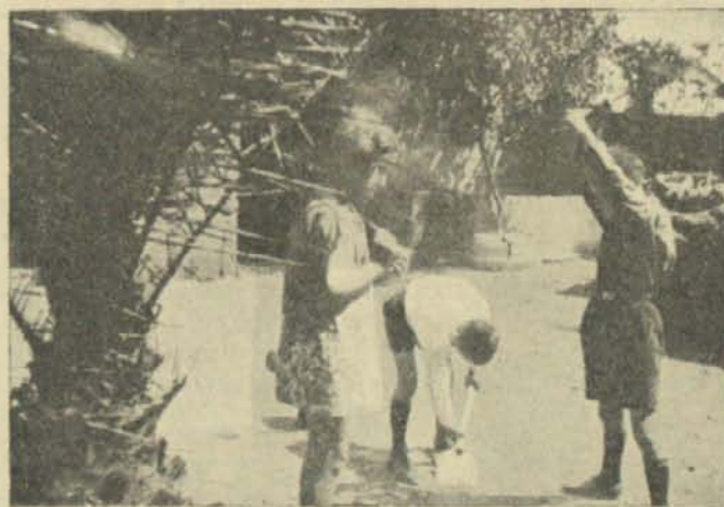
Construyendo un canalillo para que corra el agua
