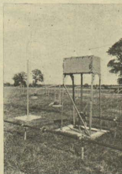
Caja de acoplamiento de antena, que conecta dos de los hilos verticales al sistema de alimentación. En el interior de la caja de cobre hay bobinas equilibradoras.
