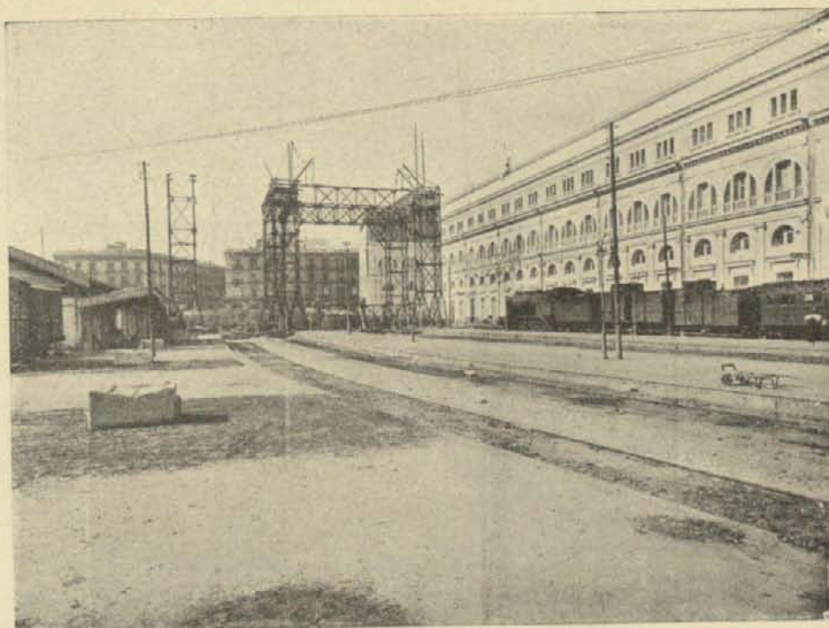
Vista del ala izquierda de la nueva estación de M. Z. A., por su fachada interior que da al futuro patio de vías y andenes. Se ve la gran torre móvil de hierro que servirá para montar la monumental doble marquesina
