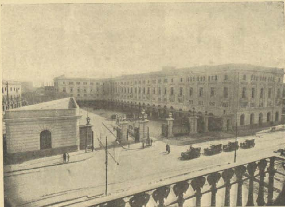
Vista del ala izquierda de la nueva estación de M. Z. A. en Barcelona; parte recientemente inaugurada. Se ven los patios de carruajes, que dan acceso a las salas de facturación y entrega de equipajes
