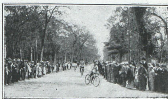
Un viraje peligroso
