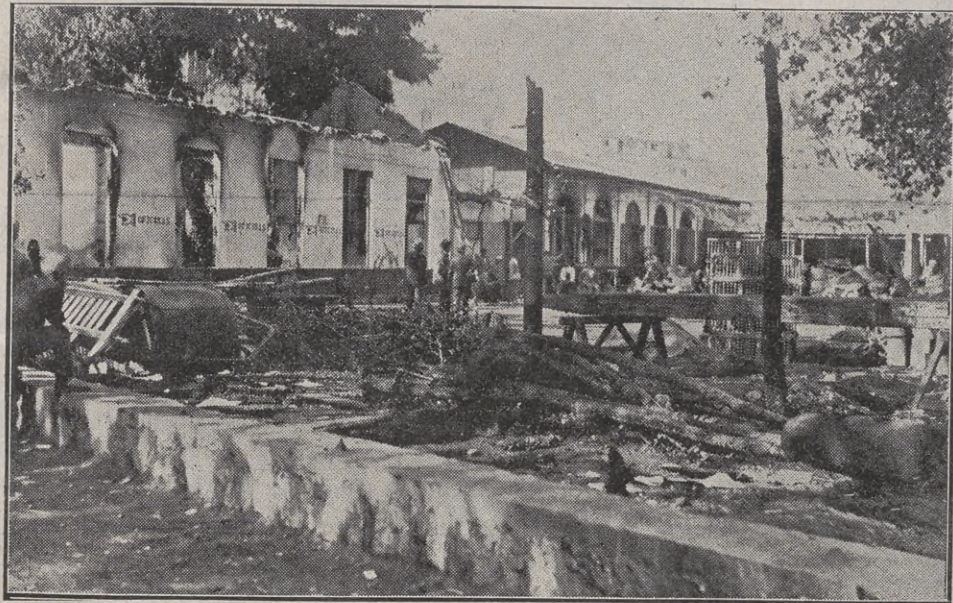
Estado en que quedaron las oficinas y almacenes de «La Patronal»
