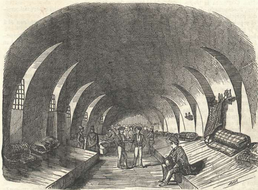
Galería general del piso bajo.
